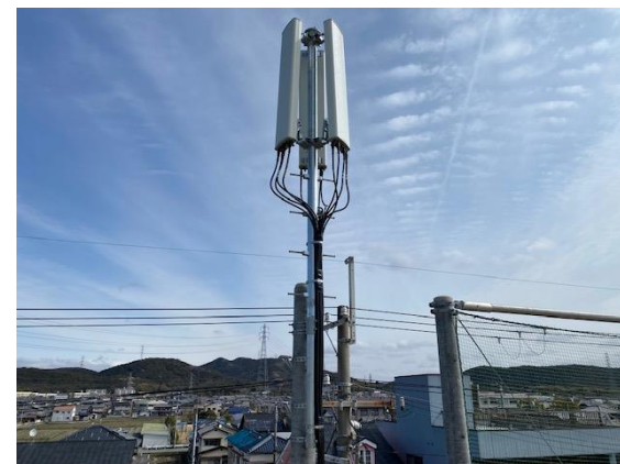
セクタアンテナ (8T8R/3セクタ) 設置
