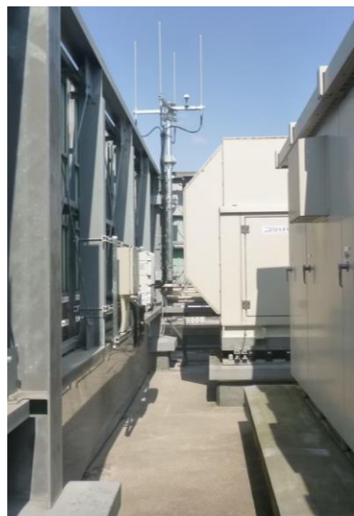
ルーター設置
