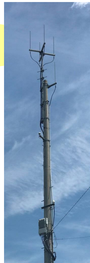
コンクリート柱設置
