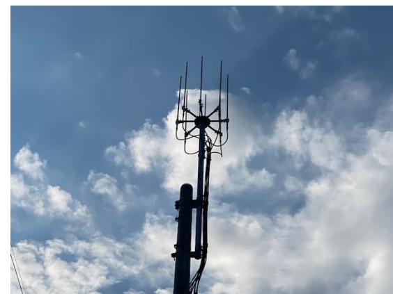
オムニアンテナ (8T8R) 設置
